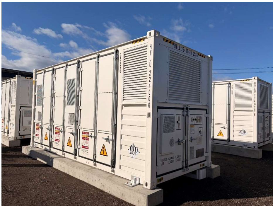
大規模コンテナ型 BESS
